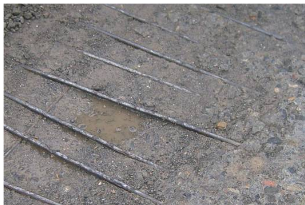
写真-1 凍害による床版の劣化損傷事例
