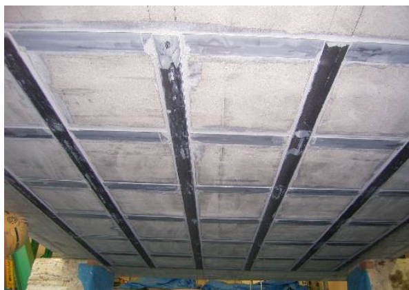
写真-6 CFRP プレートによる補強
