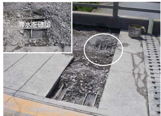
写真-2 床版上面の砂利化現象
