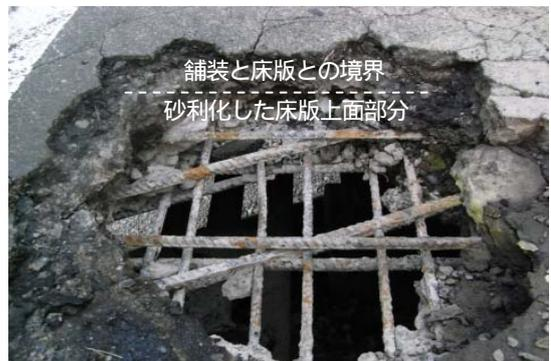
写真-3 砂利化後の押抜きせん断破壊
