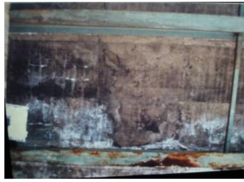
写真-8 床版を支持する桁の腐食
