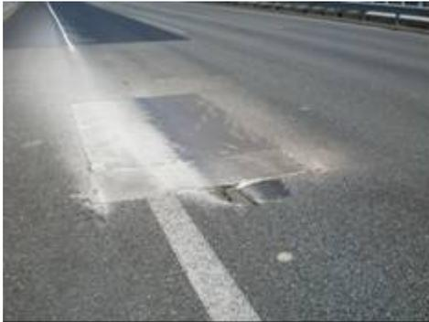
写真-5 補修した舗装の再損傷
