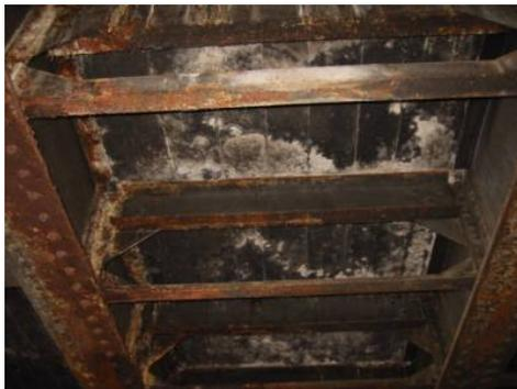
写真-7 床版を支持する桁の腐食
