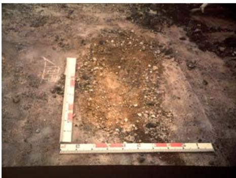
写真-6 舗装下の床版骨材化
