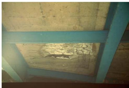
写真-3 床版下面の遊離石灰沈着
