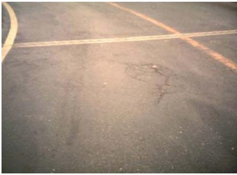
写真-4 舗装のひび割れ損傷
