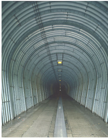
写真－１ 道路等覆工の横坑への使用例
