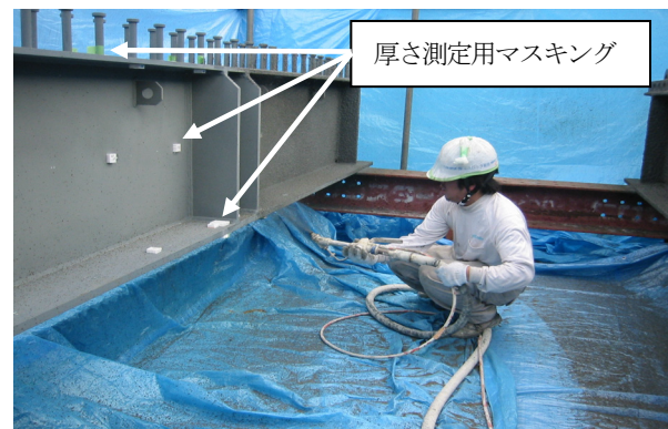
図-3 吹き付け施工試験の状況 (下フランジ下面の施工時)
