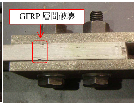
(a) 破壊状況
