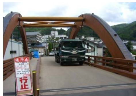
写真-5 試験車両走行試験
