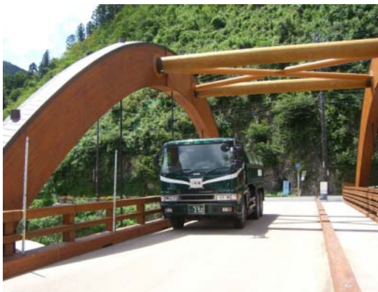
写真-3 静的載荷試験
