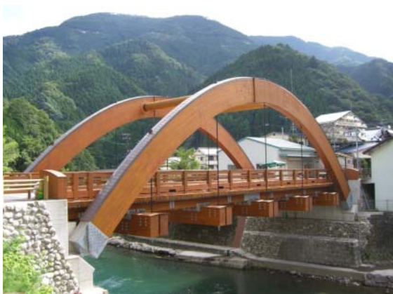
写真-2 対象橋梁全景
