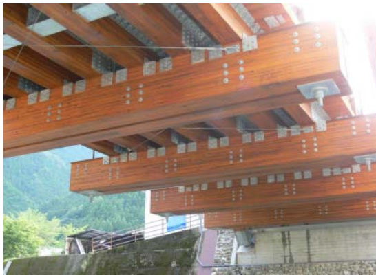
写真-1 床組構造
