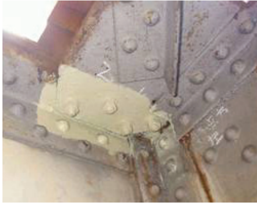
写真-1 高力ボルト置換工法の例
