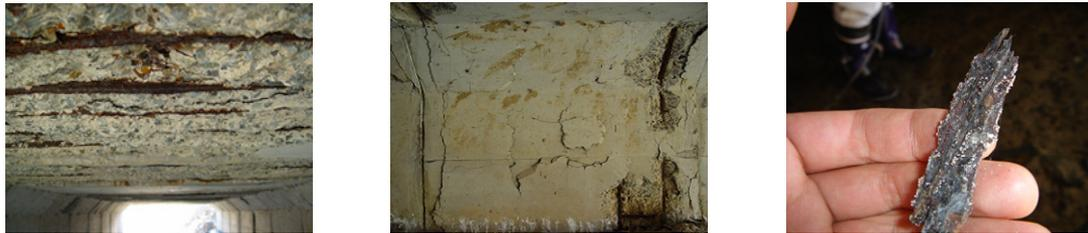
(a) 床版下面の劣化損傷状況 (b) 側壁の劣化損傷状況 (c) 鉄筋表面の剥落片
