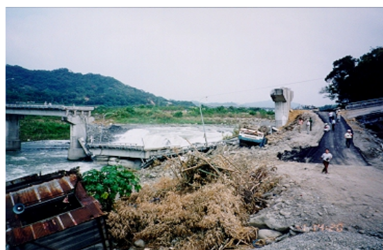
写真-1 断層変位による落橋
