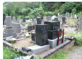
写真-1 地震被害調査で撮影された補強墓石の転倒の様子
