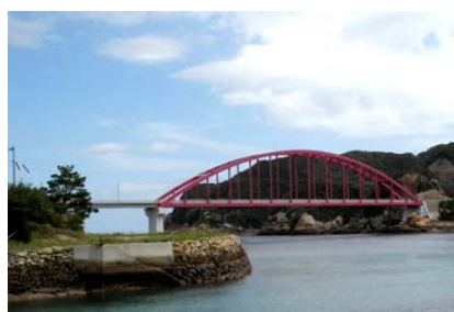
a) 橋梁側面
