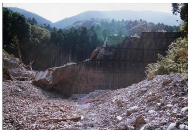
写真-1 鋼製枠砂防堰堤崩壊事例
