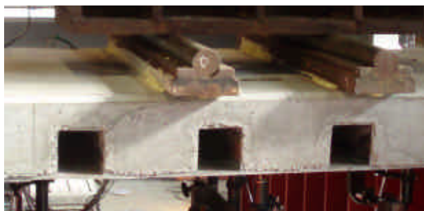
図 - 9 橋軸方向供試体の破壊状況
