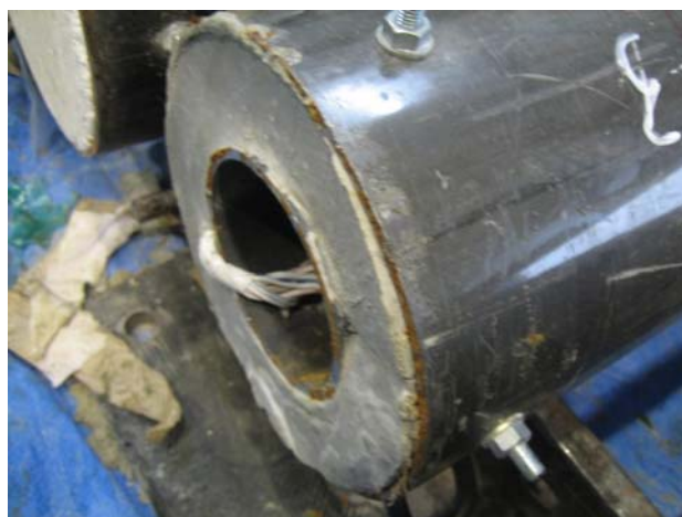
図 11 CFDT の鋼管とモルタルのずれ
