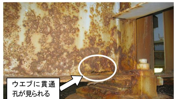
図-1 鋼道路橋の桁端部における腐食事例
