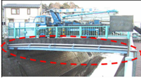
図-1 通信専用橋設置状況
