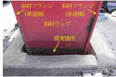
写真-1 D4 圧縮斜材の腐食状況 (第 2 径間)
