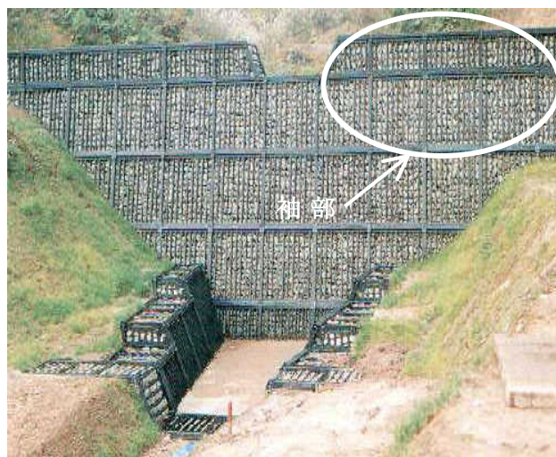
写真-1 鋼製枠砂防堰堤
