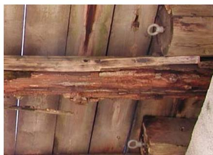
写真-2 木橋に見られる腐朽の例
