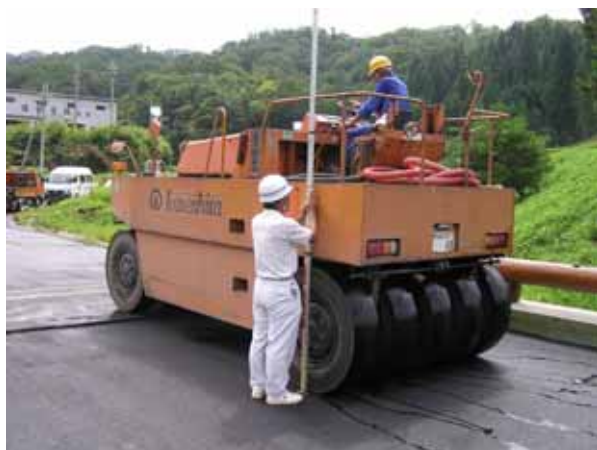
写真-5 モデル橋の載荷試験の載荷の様子
