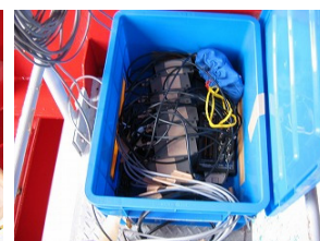
c) 加速度計用アンプ収納状況
