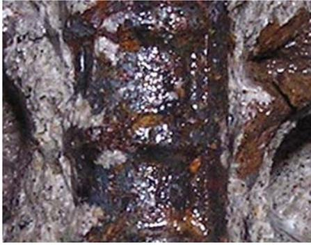
写真一 鉄筋腐食状況写真例(コアNo.18近傍)
