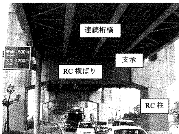
写真-1 RCラーメン橋脚の都市内高架橋
