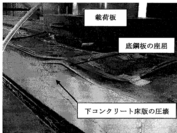
写真-1 TYPE-C の破壊状況
