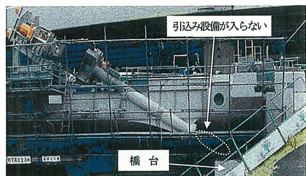
写真-1 橋台とケーブル定着部
