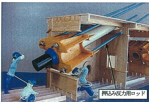
(c) 美原大橋(押し込み工法採用)
