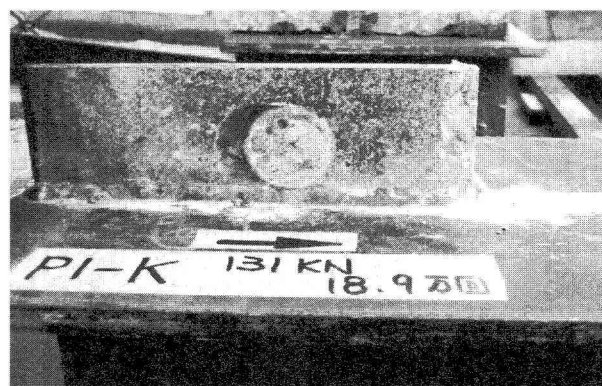
写真－５ 孔あき鋼板ジベル破壊状況
