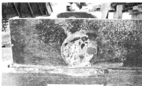
写真－６ 孔あき鋼板ジベル破壊状況（写真－５の裏面）
