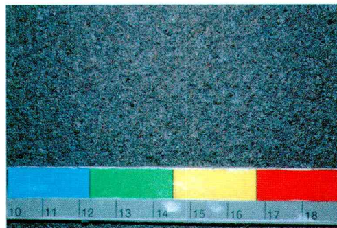
(d) 中桁上流側面 (外観評点 3)
