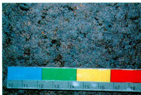
(e) 上流側桁内面 (外観評点 2)
