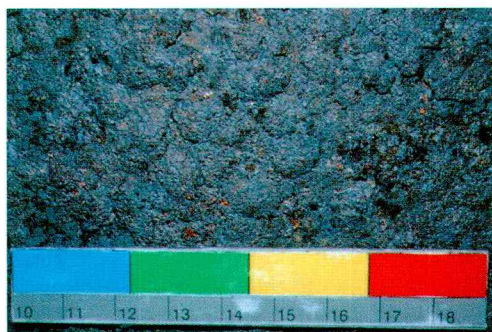
(c) 中桁下流側面 (外観評点 2)
