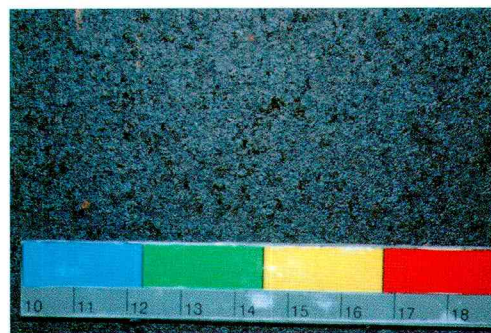
(f) 上流側桁外面 (外観評点 3)
