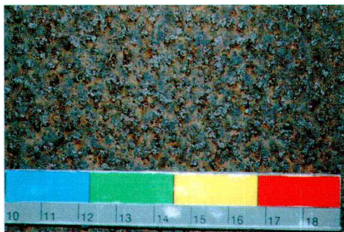
(a) 下流側桁外面 (外観評点 4)
