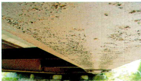
(b) 表面処理被膜の剥離中 (評価 A)
