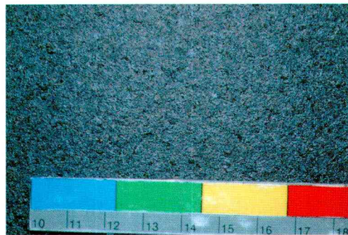
(b) 下流側桁内面 (外観評点 3)
