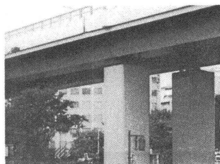
図-2.1 独立柱橋脚を有する橋梁
