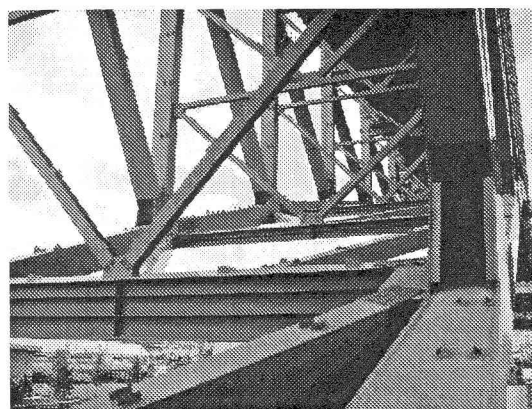
写真 1 既設長大橋の輻輳する部材構成状況
