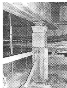
図-10 振動対策工
