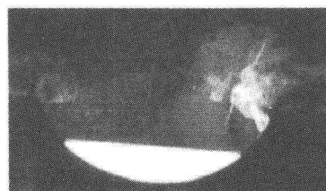
写真-1 疲労亀裂
