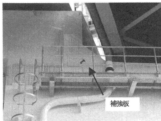
図-22 補強板（補強工事後）
