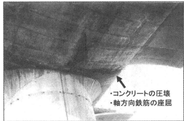
写真-2 主塔・主桁剛結部付近の主桁の損傷
