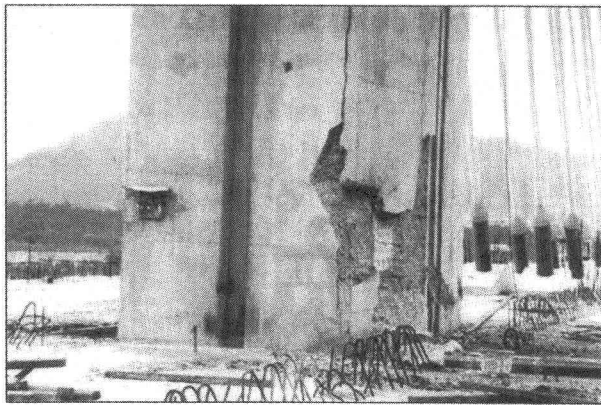
写真-1 主塔基部のコンクリートの剥落
