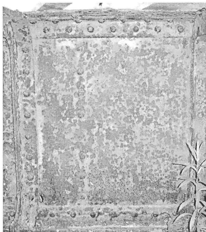
写真-1 支承部付近におけるウェブの外観
