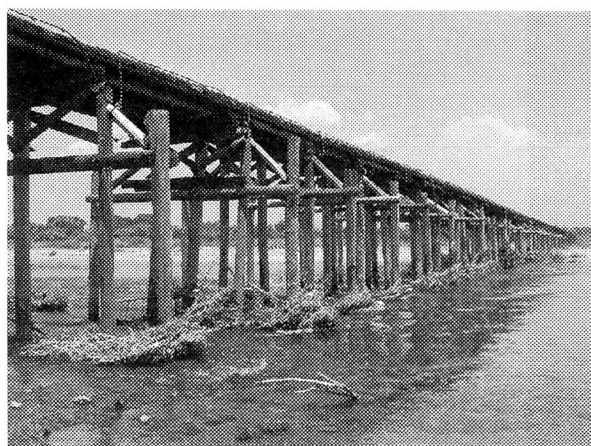
写真-1 上津屋橋
