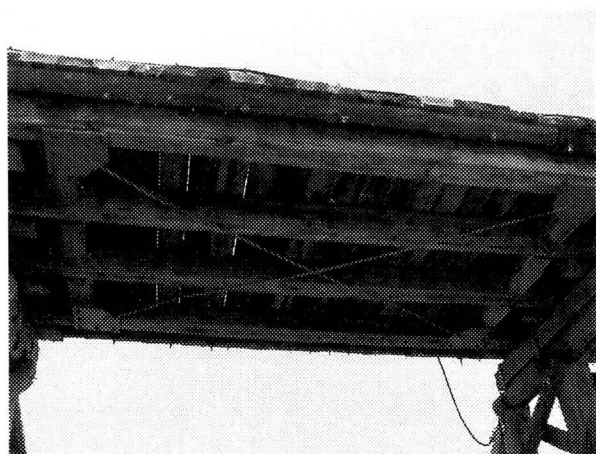
写真-3 上津屋橋の上部構造
