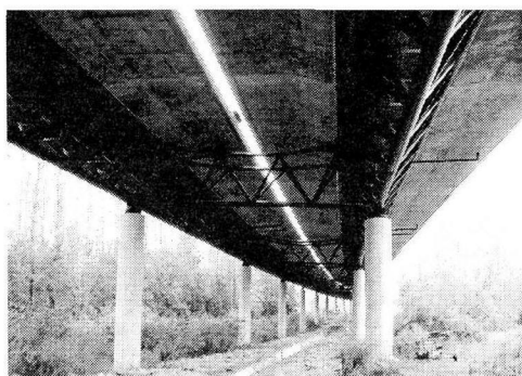
図-1 パイプトラス橋 (Lully高架橋)
