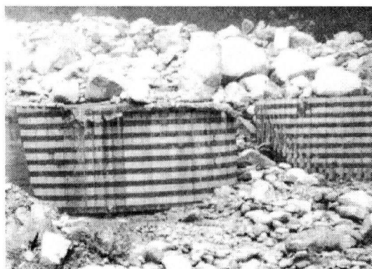
写真-1 セル型砂防ダム
