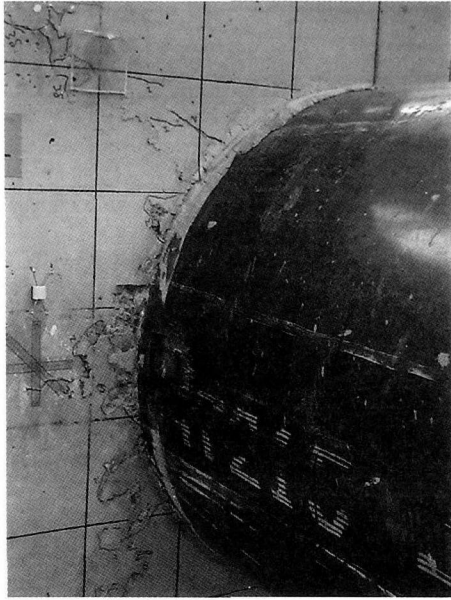
写真-1 終局時コンクリート圧縮破壊状況
