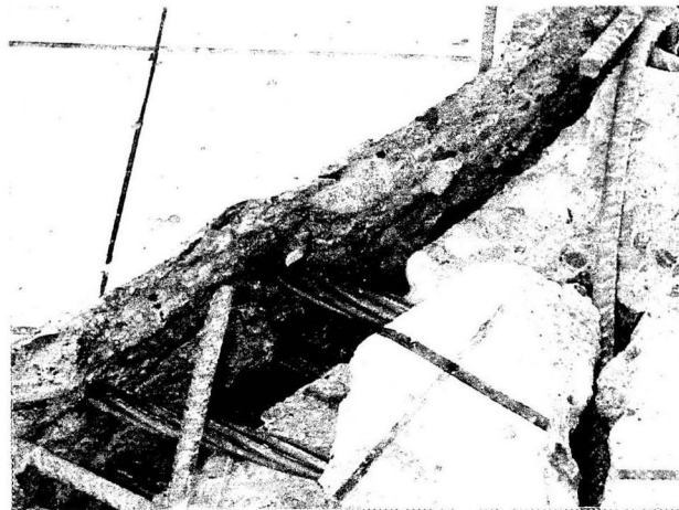
写真-3 スターラップ破断面
