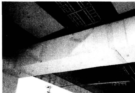
写真-1 鋼製ラーメン梁腹板のせん断座屈被害例
