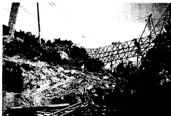
写真-4 倒壊した345kV超高压送電鉄塔 (中寮～峨眉間の#203)
