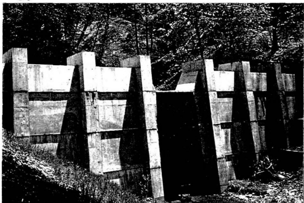
写真-7：縦壁ダムの完成状況
