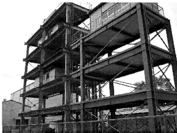
写真-2 実大構造実験施設
