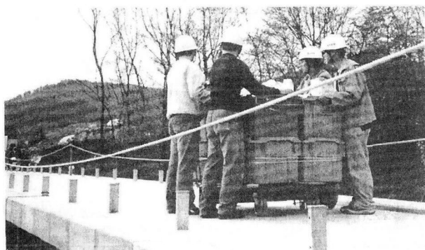
写真-3 静的荷重の移動載荷
