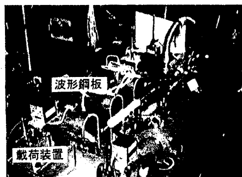
写真-1 載荷状況
