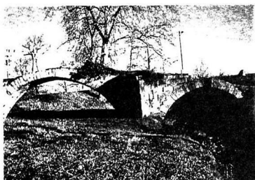
写真-1 ポミエール橋
