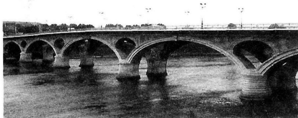
写真-2 カタラン橋
