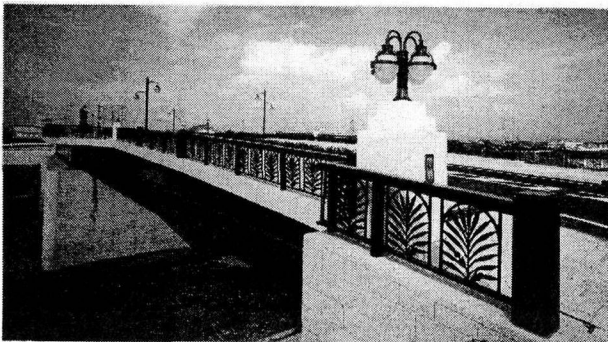
図-3 SD プロフィールに該当する橋（No.64:静橋）
