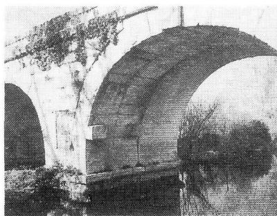
写真-11 ボワセロン橋 (著者撮影)
